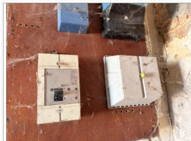
Appareil général de commande et de protection
